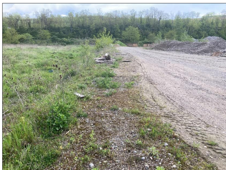
Abb.3: Abbruchkante am nördlichen Ende des Geltungsbereichs.
